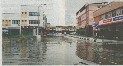
Laluan jalan di sebahagian premis kedai di Pekan Banting ditenggelami air disebabkan hujan lebat.
